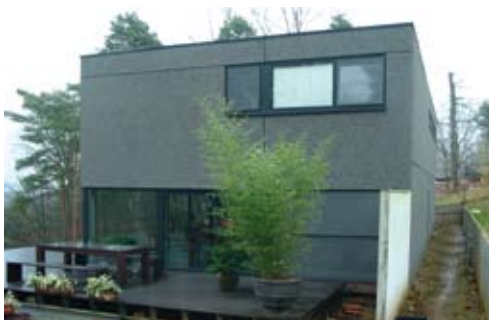
2 Woning te Holsbeek – Aiko arch., Maldegem
